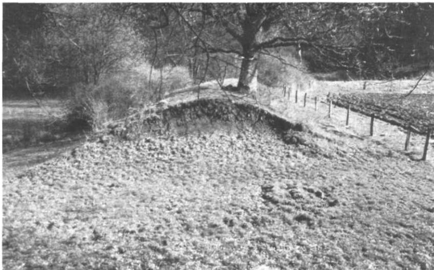
10. Chaussée de l'étang du moulin de l'Huilerie (cliché B. Rouzeau).
