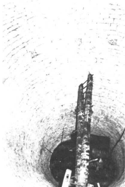
Vue plongeante et fort impressionnante sur le puits en forme de pain de sucre renversé. Dans le fond : débris divers. Sur la paroi, on distingue très bien les alvéoles destinées à recevoir des poutres.
