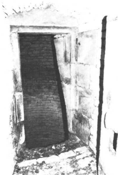
Emplacement de la deuxième porte : les gonds subsistent encore. Il faut remarquer :
