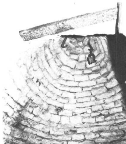
Le sommet de la coupole est entièrement maçonné. On y distingue : deux forts crochets en fer forgé dont l'un porte encore les vestiges d'une poulie en bois à gorge.
