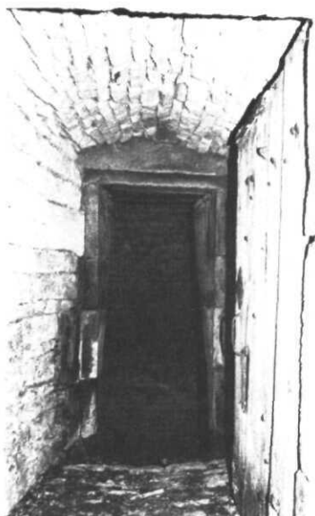
Vue sur la porte d'entrée, le couloir et l'ouverture de la seconde porte donnant directement sur le puits.
